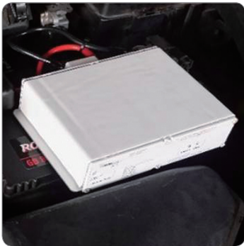
상부, 하부 에어로젤 단열 후 백크로 테이프로 고정
